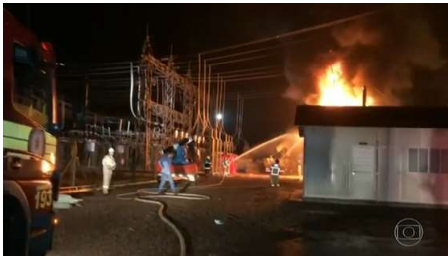
Figura 3 – Incêndio em subestação de energia na Zona Norte de Macapá (03/11/2020).
